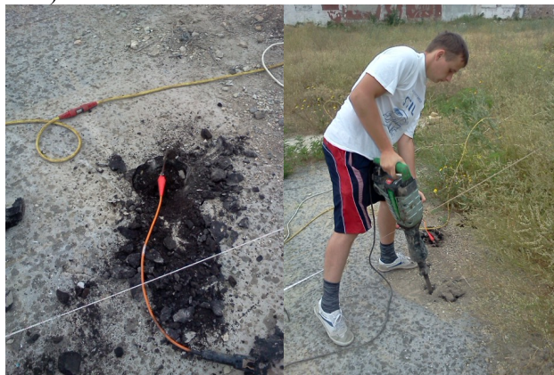
Рисунок 1 Пример заземления стальных электродов на участке работ с асфальтным покрытием.
